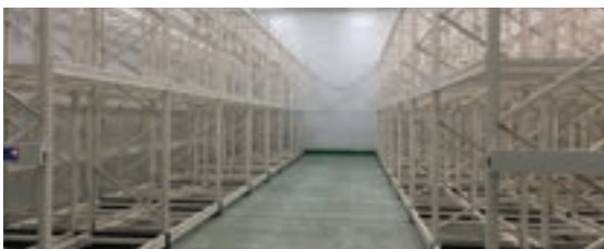
ตัวอย่างการติดตั้งในไทย Mobile Rack ห้องแช่แข็งแบบมีรางนำทาง และแบบไร้ราง
