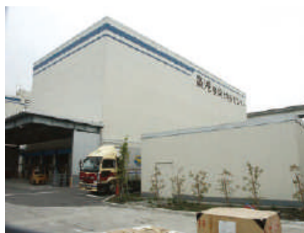
● อาคารเก็บก๊าซ CO 2 (ขวา)
